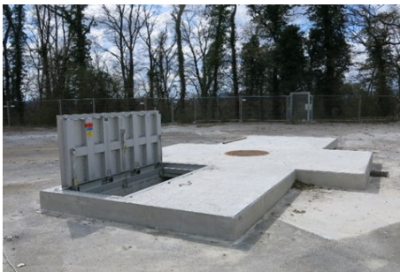
Nur der Bohrkeller bleibt zurück, ansonsten wird der Bohrplatz zurückgebaut.
